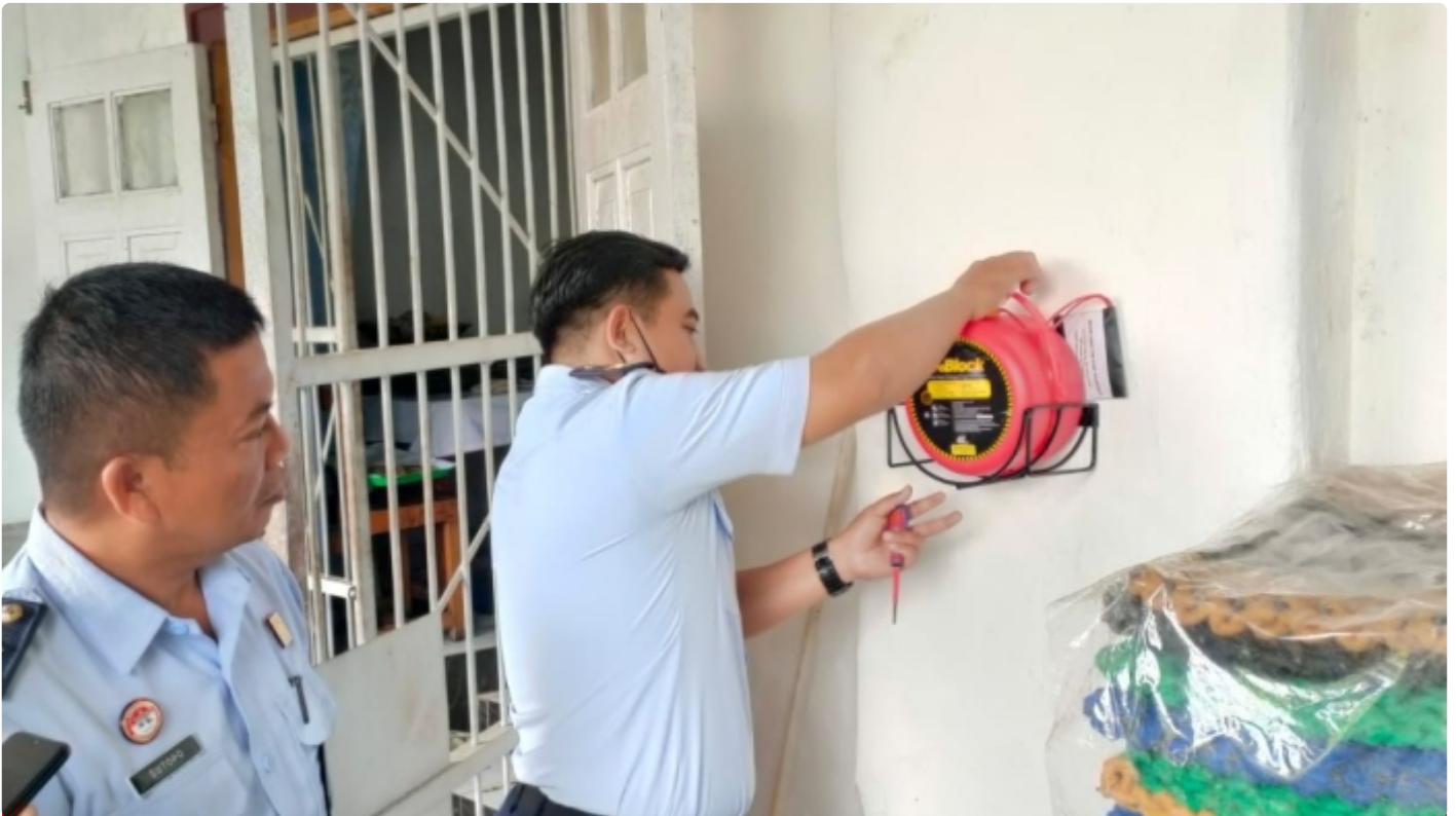
Antisipasi Kebakaran, Lapas Ambarawa lakukan Pemasangan APAR
